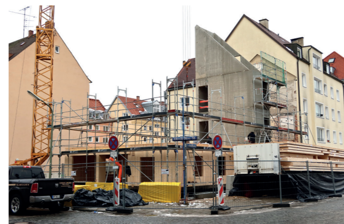
Das Erdgeschoß ist aufgestellt, der Treppenhauturm ragt heraus
