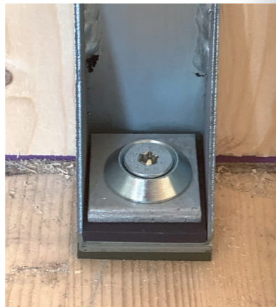
Zuganker mit Schallentkopplung
